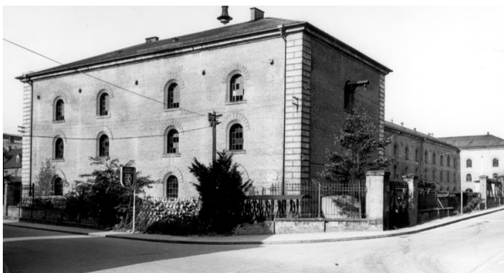
Unterer Graben: Zeughaus
